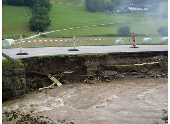
Der Schlattenbach legte Kabel frei...
