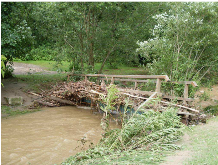
...und riss eine Brücke mit sich
